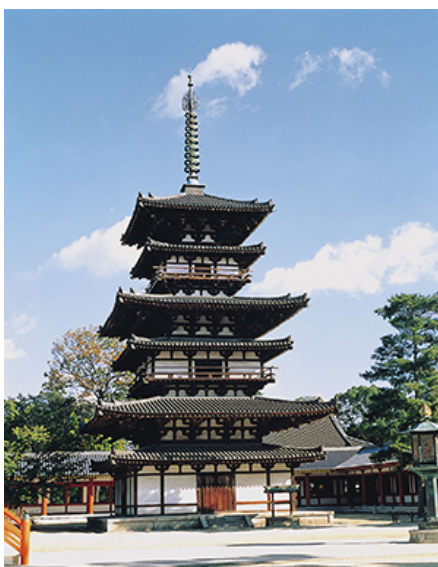
日本の中西部・奈良県にある薬師寺東塔。法隆寺の五重の塔と同様に、塔の中心部に心柱が使われています。 (写真提供：奈良市観光協会 ©矢野建彦)
